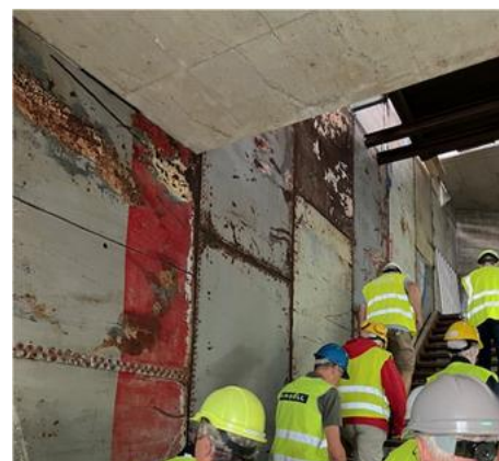
Væg i trappeskat beklædt med stålplader fra gamle siloer
