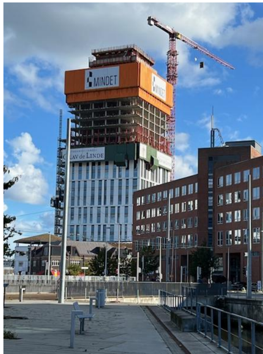
Byggeri undervejs 5. september 2025
